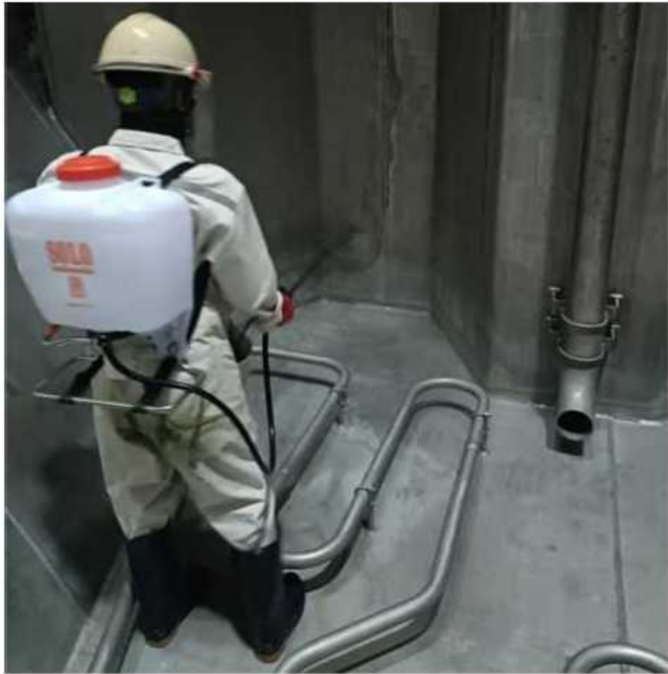
Gambar 3.2 Pelaksanaan Tank Cleaning . Sumber : Dokumen Pribadi
