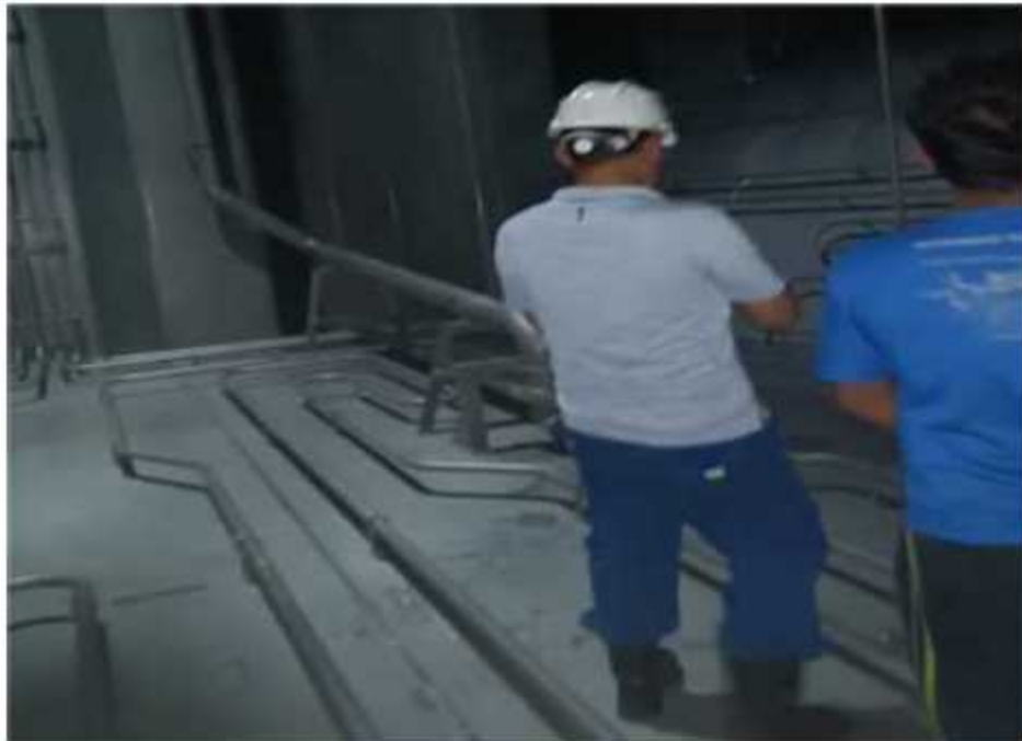
Gambar 3.4 Tank Inspection Sumber: Dokumentasi Pribadi
