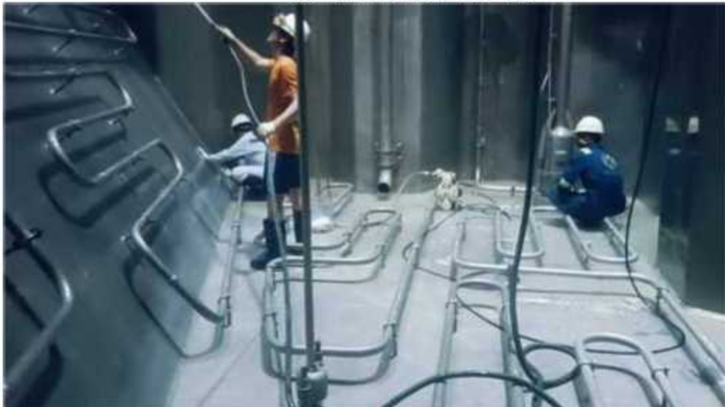
Gambar 3.3 Pelaksanaan Tank Cleaning . Sumber : Dokumen Pribadi
